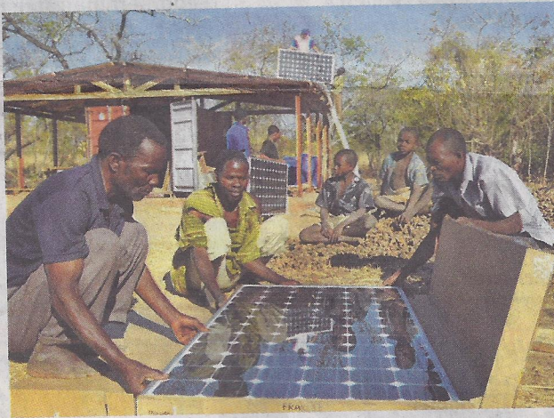
Montage von Solar-Kollektoren für den Stromcontainer in Malawi.
